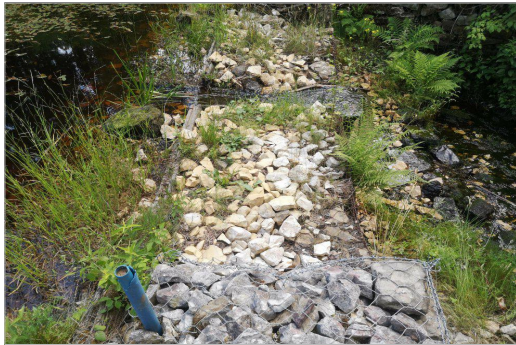
zdj. nr 2 - uszkodzone zamki koszy, luźny narzut na przelewie
