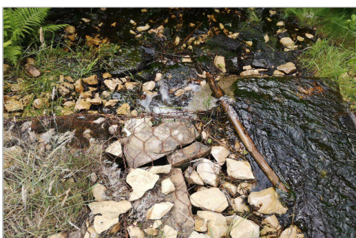
zdj. nr 7 - siatka pokryta korozją, uszkodzony zamek - przelew
