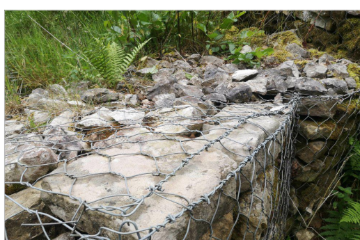
zdj. nr 10 - uszkodzenie zamka
