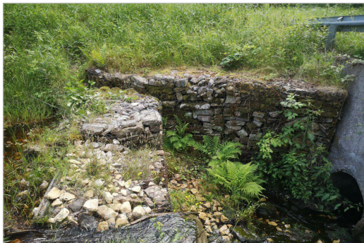
zdj. nr 3 - luźny narzut poniżej przelewu, uszkodzenie zamków - brzeg lewy
