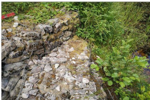
zdj. nr 4 - rozpięty zamek kosza na przelewie - brzeg prawy
